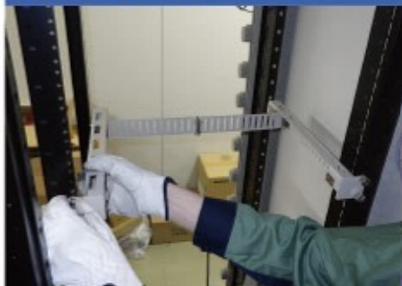
1 補助ステーを仮設置
