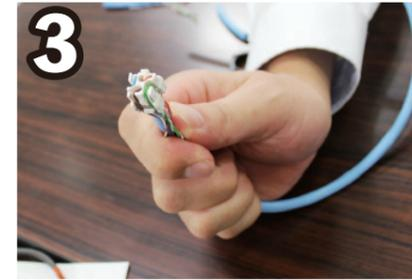
ケーブルペアの撚りを崩さず、ケーブルマネージャのくぼみの外側に白の絶縁体がくるようにはめます
