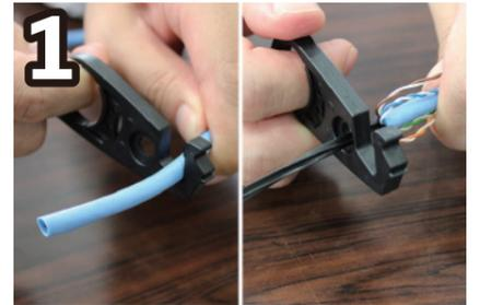
ケーブルツール (RVUTT01) を使用して、シースを剥離します。ケーブルを 2 つのグループに分けて、十字介在を切断します
